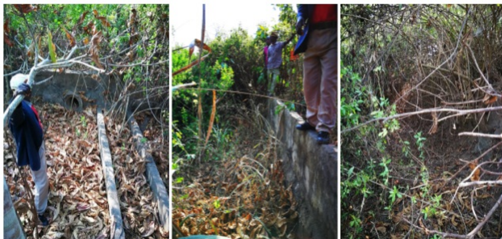
Ejemplos del estado actual de la infraestructura de riego y rehabilitación
