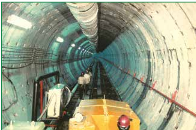
FIGURA 10. Vista al interior del Emisor Central (1975)
