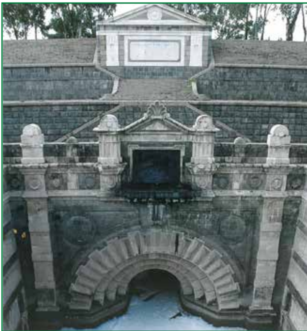
FIGURA 6. Portal de entrada del 1er Túnel de Tequixquiac
