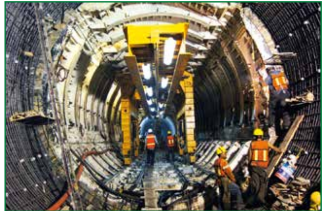
FIGURA 25. Colocación de revestimiento, Túnel Emisor Oriente
