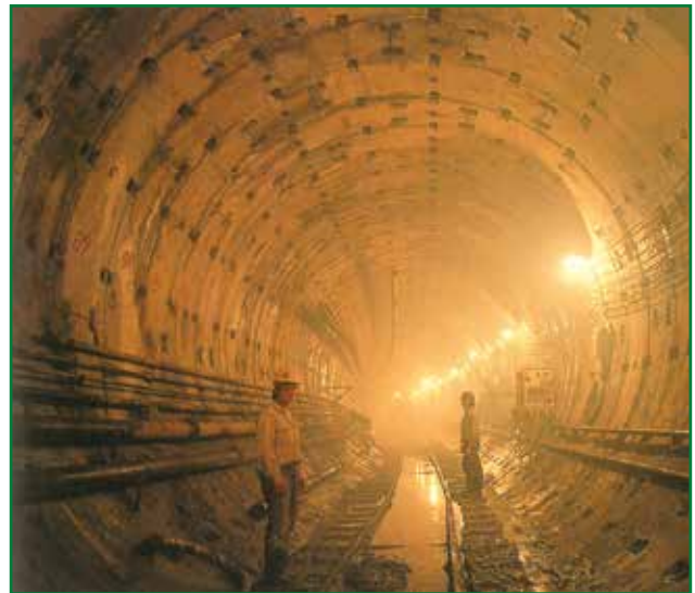
FIGURA 9. Interceptor Central, Drenaje Profundo (1979)
