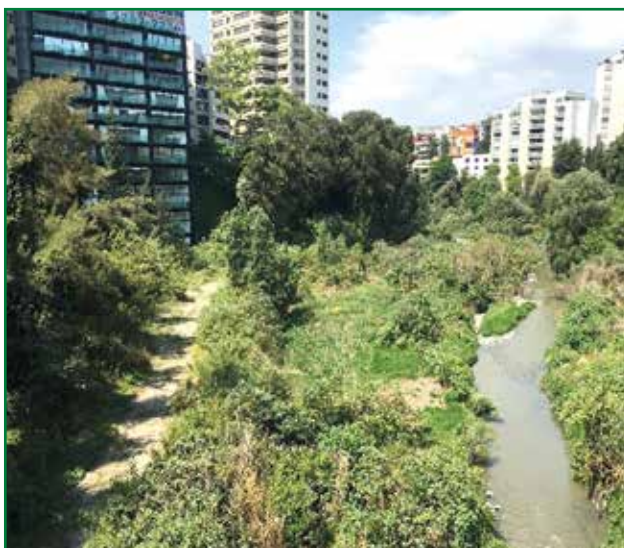
FIGURA 7. Construcciones al interior del vaso de la presa Tecamachalco
