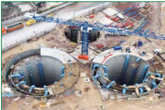
FIGURA 13. Construcción del Túnel Emisor Oriente
