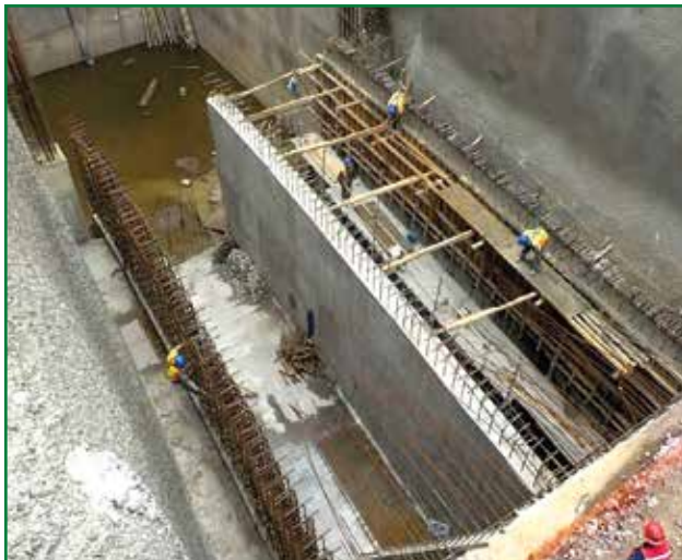
FIGURA 24. Trabajos de obra en la captación del río San Javier (TEP II).
