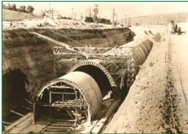
FIGURA 8. Construcción de la bóveda del Emisor Poniente, ICA (1964)
