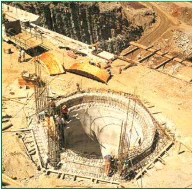
FIGURA 11. Construcción de lumbrera del Emisor Central (hacia 1970)
