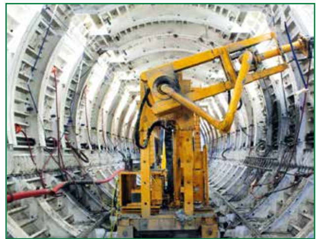
FIGURA 12. Construcción del Túnel Emisor Oriente
