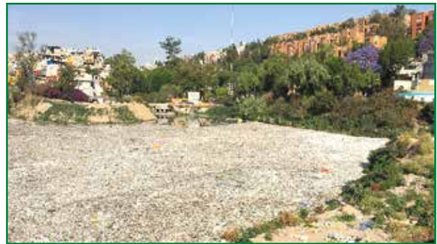
FIGURA 8. Acumulación de residuos en la Presa C de Becerra
