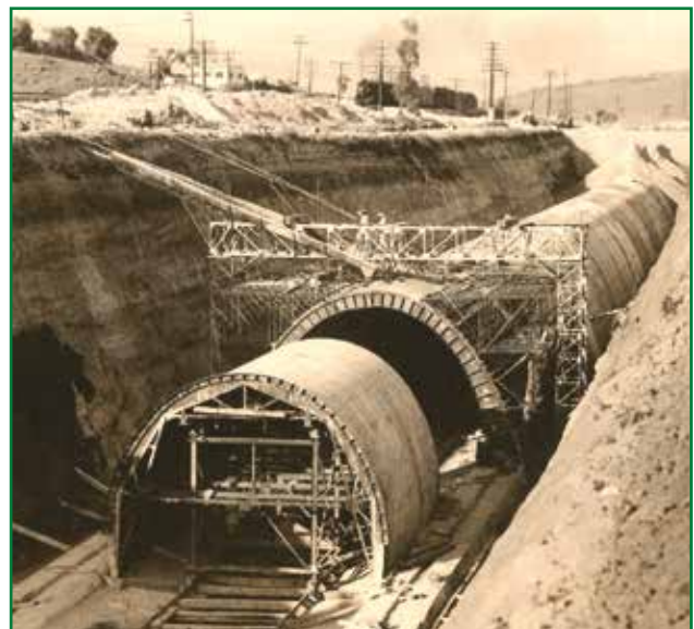
FIGURA 12. Construcción de la Bóveda del Interceptor del Poniente (1964)
