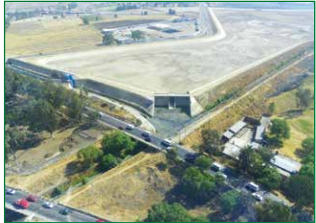
FIGURA 17. Presa de regulación La Gasera
