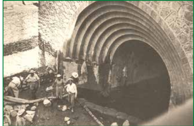
FIGURA 7. Obras del Nuevo Túnel de Tequixquiac
