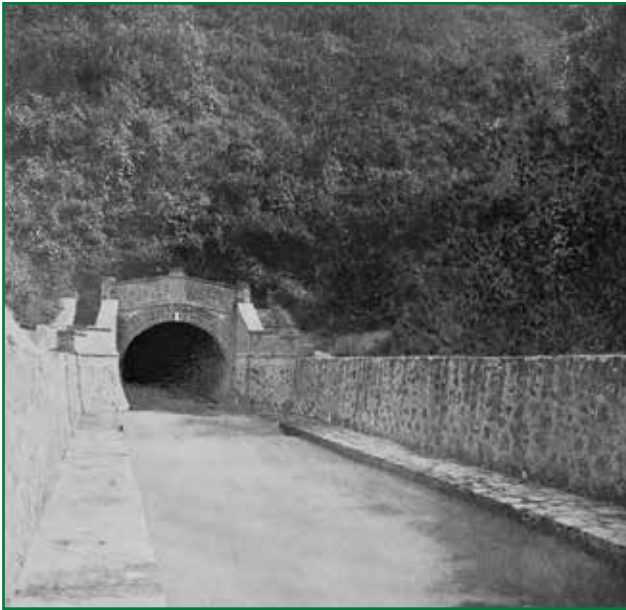
FIGURA 3. Portal de salida, Primer Túnel de Tequixquiac
