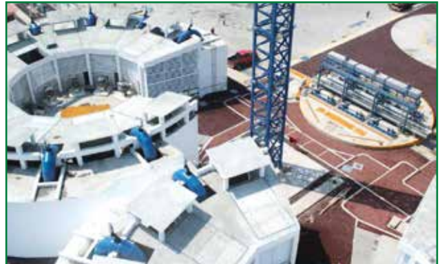
FIGURA 14. Planta de Bombeo Casa Colorada Profunda
