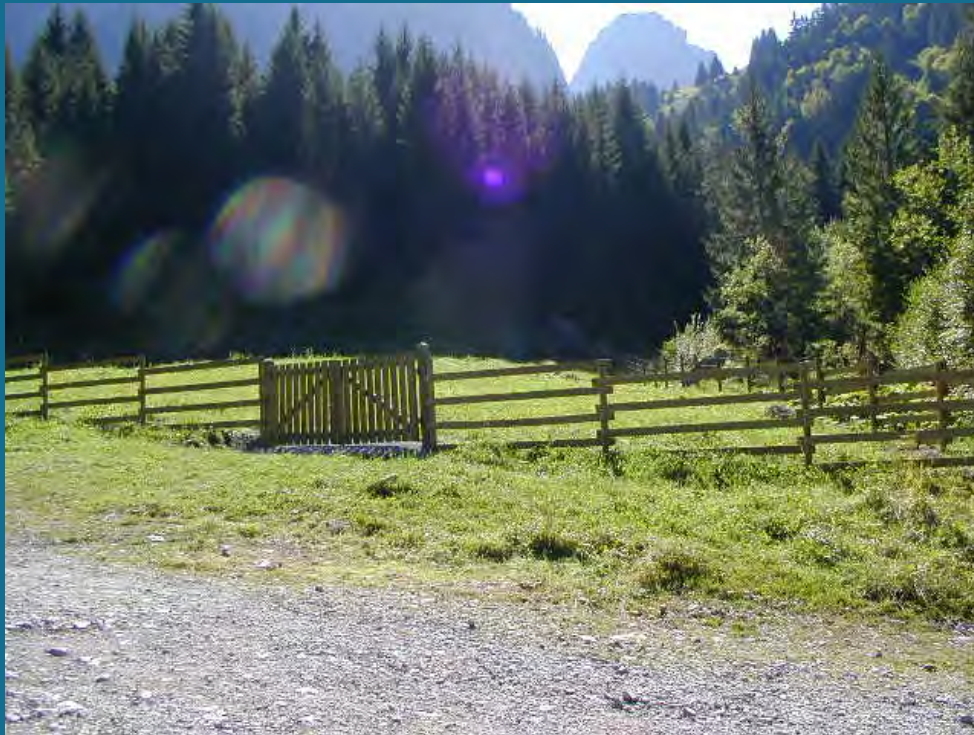
Pose de palissades "bois" en zone touristique
