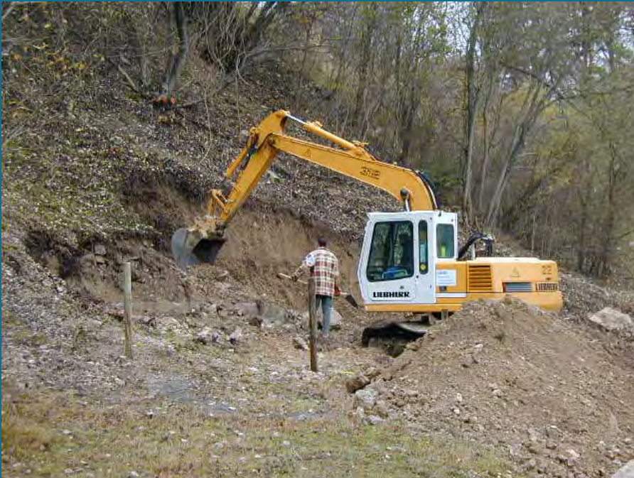
Réfection de la zone captante / captage de la source plus en profondeur
