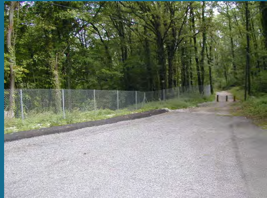
Imperméabilisation et collecte des eaux de ruissellement à l'amont des ouvrages de captage
