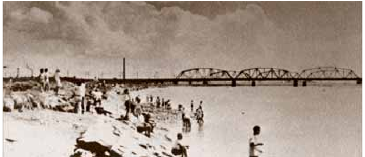
Le canal de crue de la rivière Ara une fois achevé
