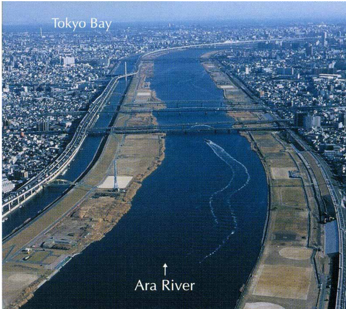
Le canal de crue de la rivière Ara
