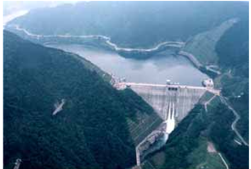
Le barrage de Miyagase
