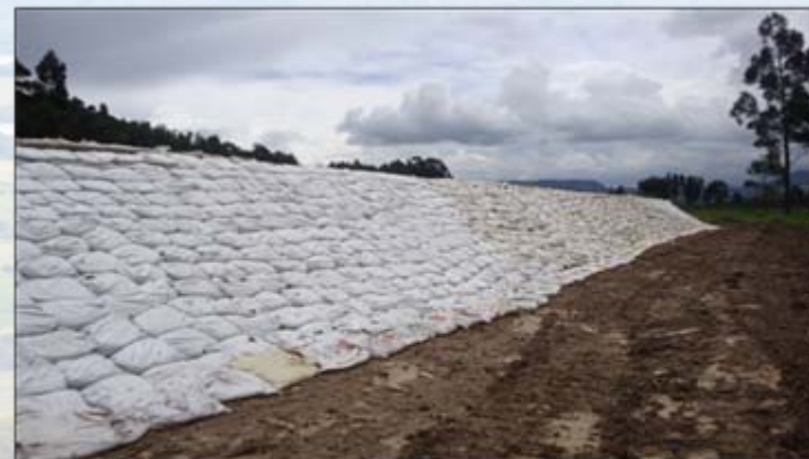
Conformación de Jarillones - Fenómeno de La Niña 2011
